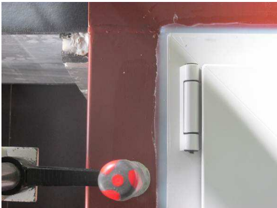
Bild 8 Scherenlager, Innenansicht
