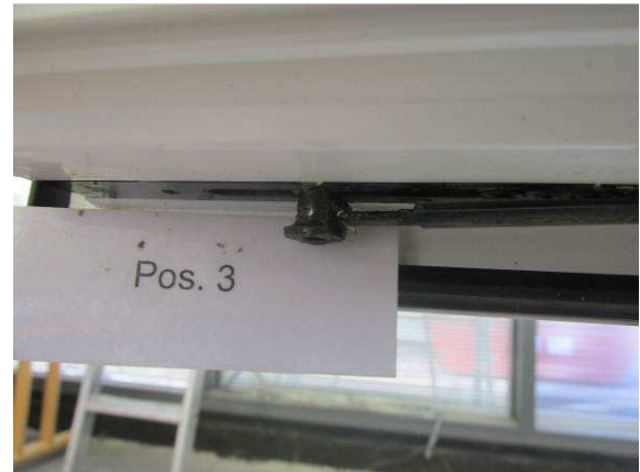
Bild 18 Verriegelungssituation Flügelrahmen 3
