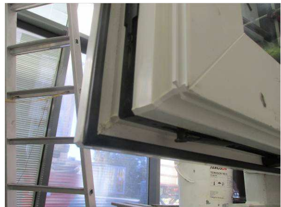
Bild 3 Innere Anschlagdichtung Eckausbildung
