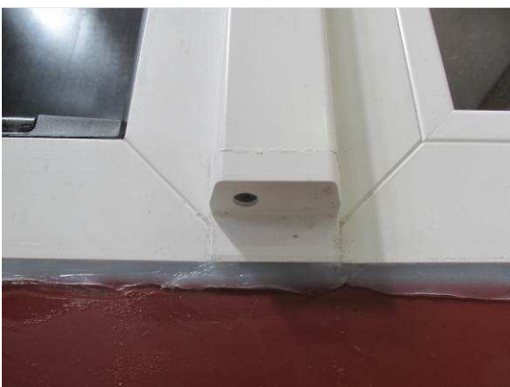
Bild 4 Kopplungsprofil, Ansicht unten
