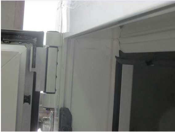
Bild 6 Scherenlager, Falzansicht
