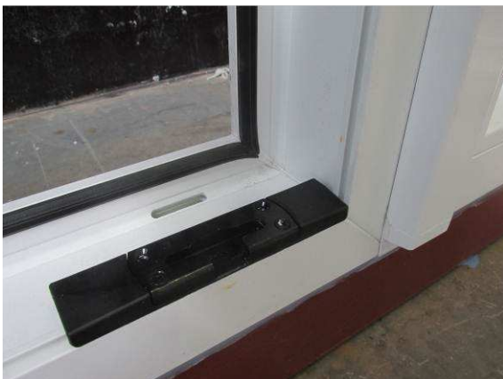
Bild 2 Äußere Anschlagdichtung, Eckausbildung
